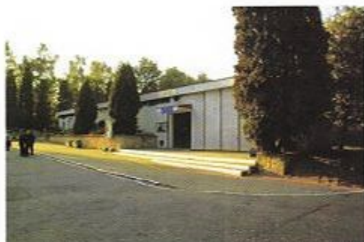
Stara kaplica na Cmentarzu Batowice, na miejscu której ma stanąć spopielarnia.
